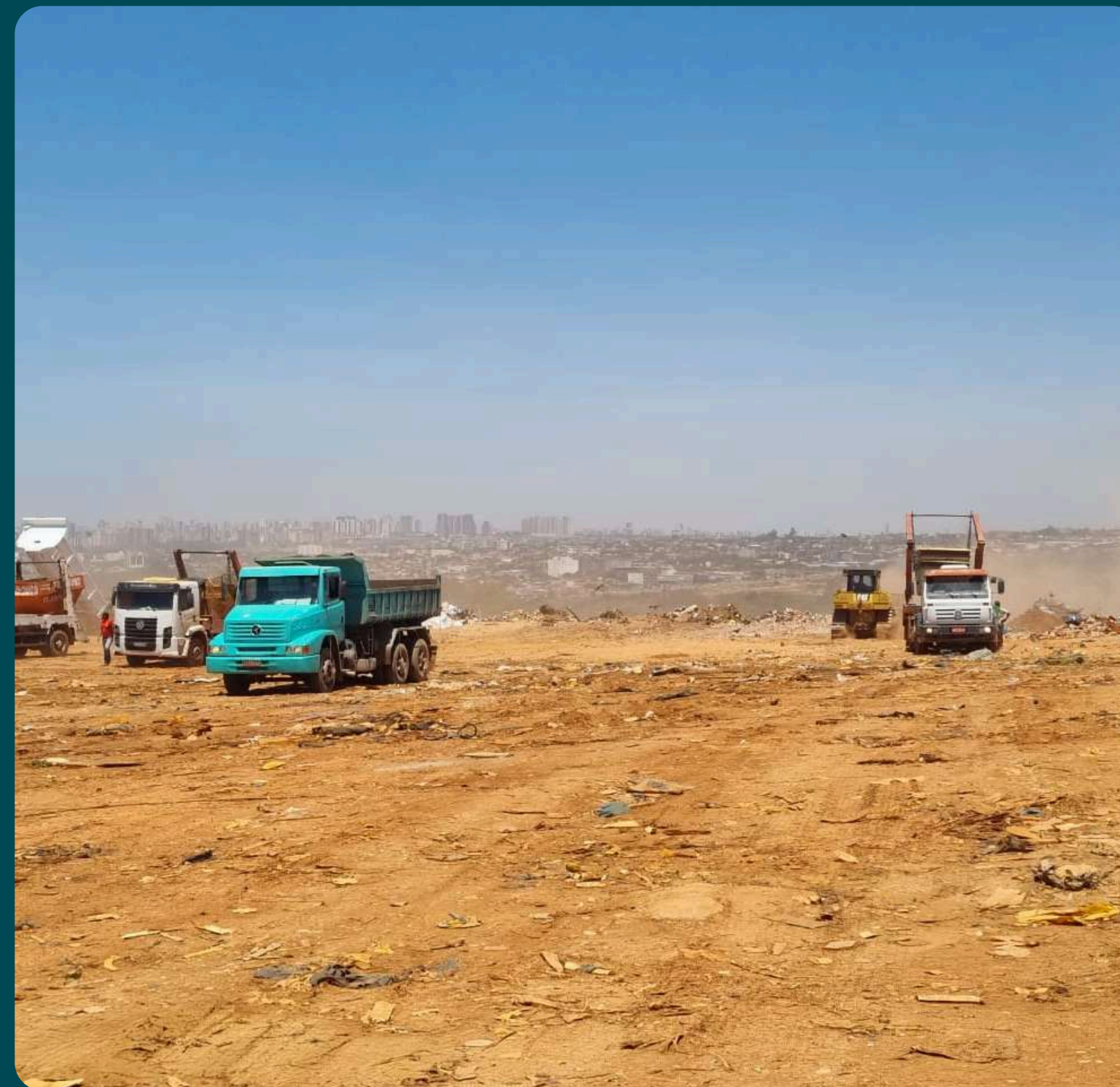
Unidade de Recebimento de Entulho - URE
