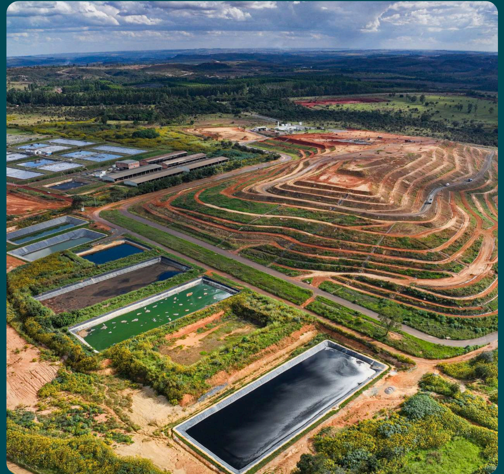
Aterro Sanitário de Brasília
