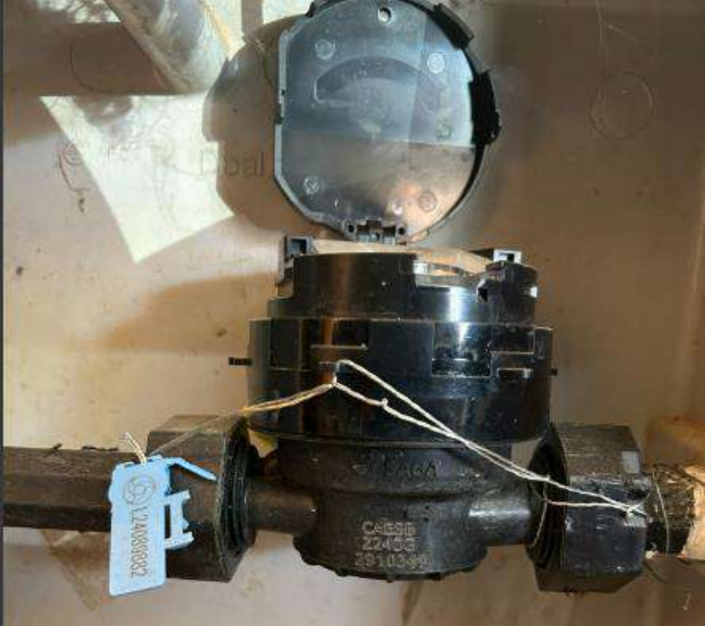
Foto 06: Hidrômetro instalado no Lote 02 – PMDF
