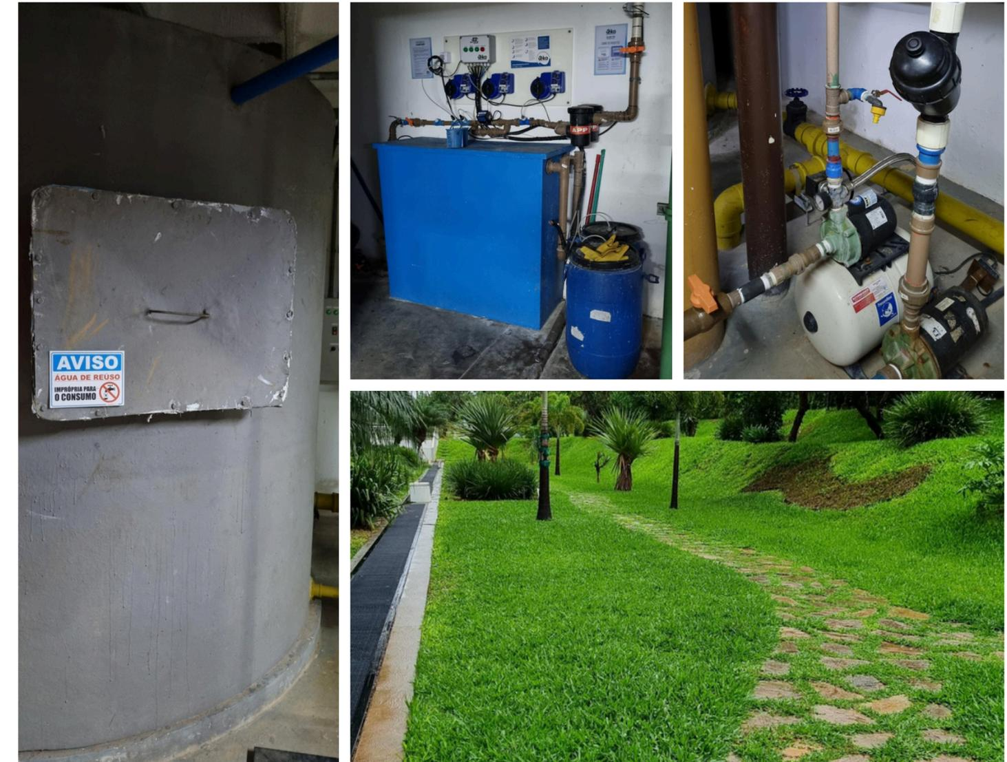
Reservatório de água de reúso; Sistema de tratamento; Detalhe do sistema de bombeamento; Parte da área de uso final.
