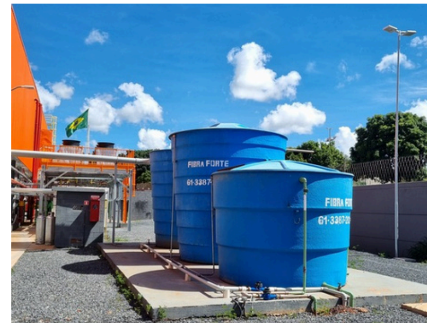
Reservatórios inferiores de água da chuva
