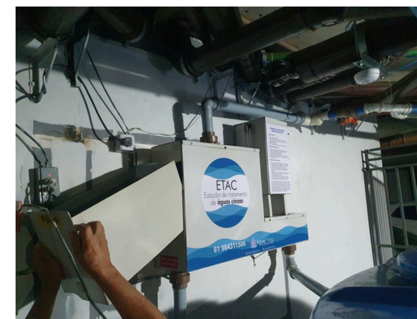
Reservatório de água não potável
