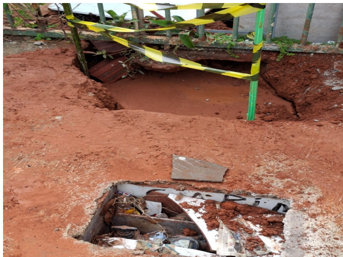
Foto 6 - Conserto do vazamento na rede de água
