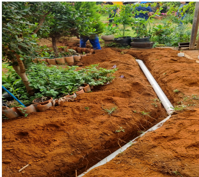
Foto 12 - Encanamento instalado até a parte inicial na caixa de ins
