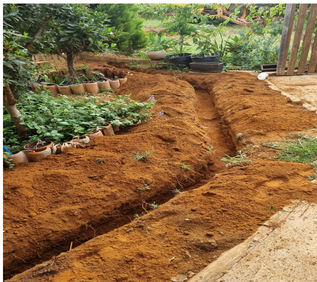
Foto 4 - Escavação para instalação do encanamento de conexão da saída da casa com o sistema Biodigestor
