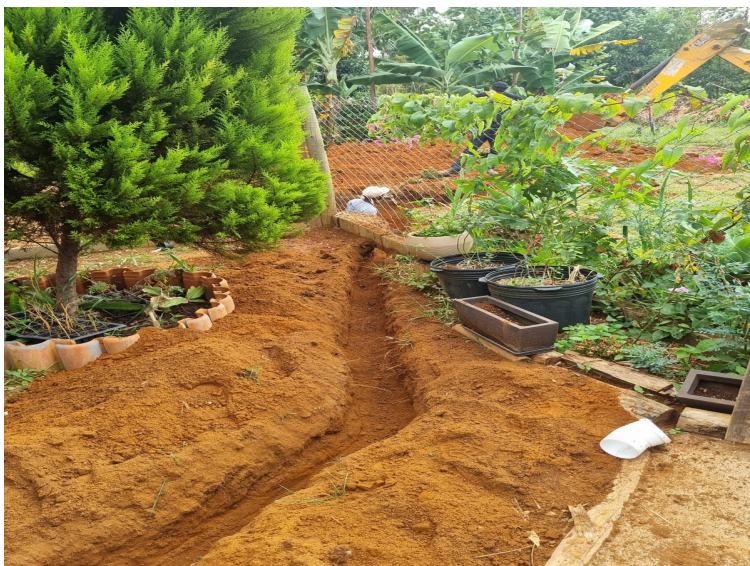
Foto 3 - Escavação para instalação do encanamento de conexão da saída do esgoto da casa com o sistema Biodigestor
