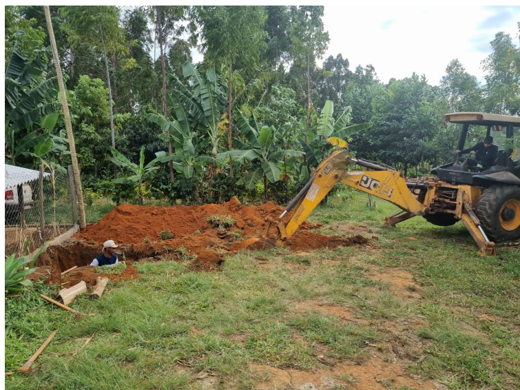
Foto 1 - Escavação inicial para instalação do sistema Biodigestor
