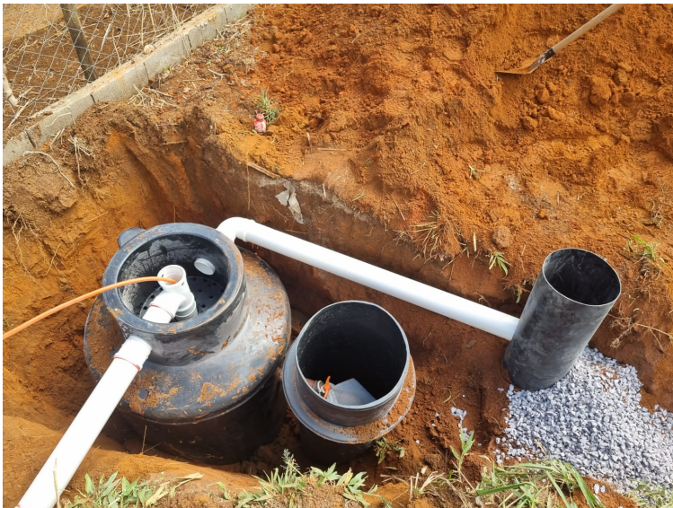
Foto 15 - Fossa séptica: Biogestor de 1000 l e caixa de lodo
