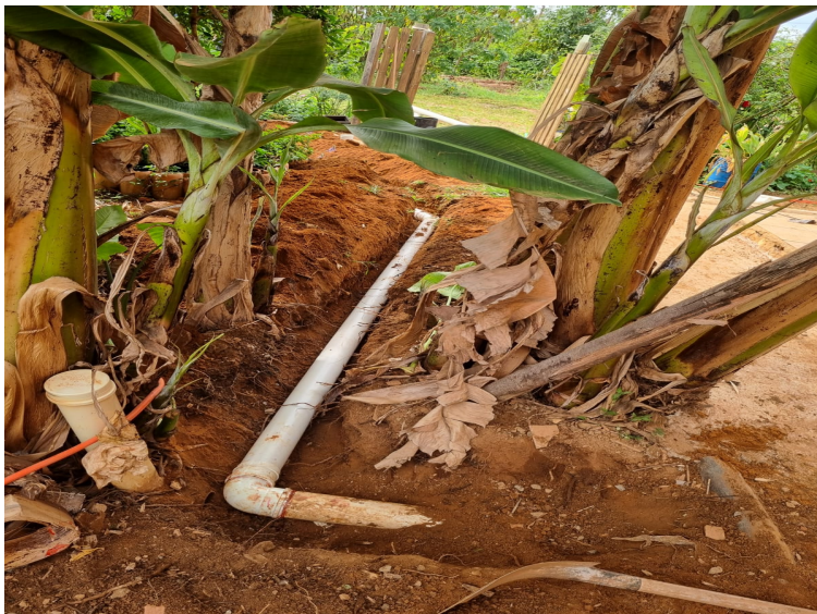
Foto 11 - Encanamento instalado da saída do esgoto até o sistema Biodigestor
