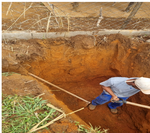
Foto 2 - Escavação de aproximadamente 2 metros para o Biodigestor de
