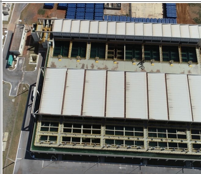
Foto 6 - Reservatórios de 10 mil m3 cada e a elevatória de água tratada
