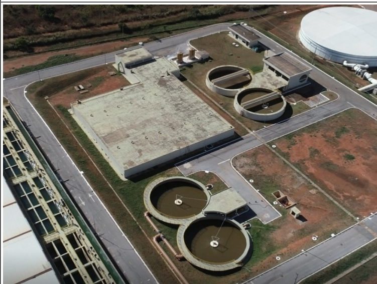
Foto 5 - Tanque de mistura de produtos químicos (tanque de contato), tanques de lodo e tanques de regularização de vazão
