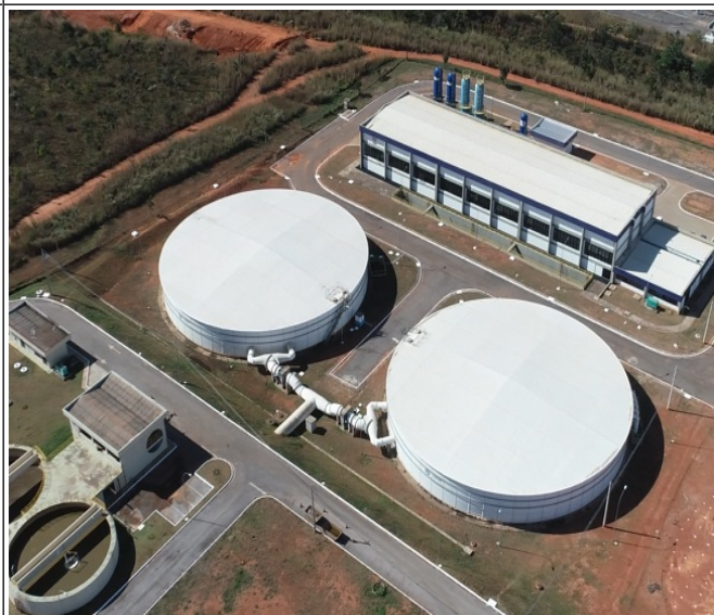
Foto 6 - Reservatórios de 10 mil m3 cada e a elevatória de água tratada
