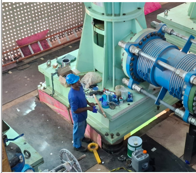
Foto 13 - O motor, parte superior da bomba, teve que ser retirad
